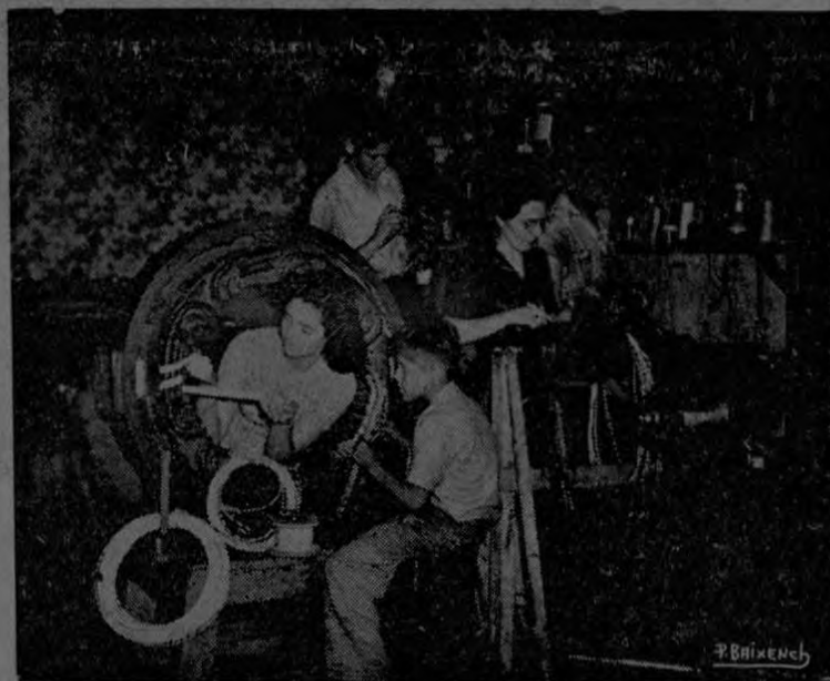
Muestra esta instantánea de izquierda a derecha, la señorita María Cristina Sánchez Sanabria embobinando un inducido de un alternador de corriente de 75 K v A, y la señorita Alice Villalobos Zúñiga haciendo pruebas técnicas de un rotor de dinamo de 10 K.W.
